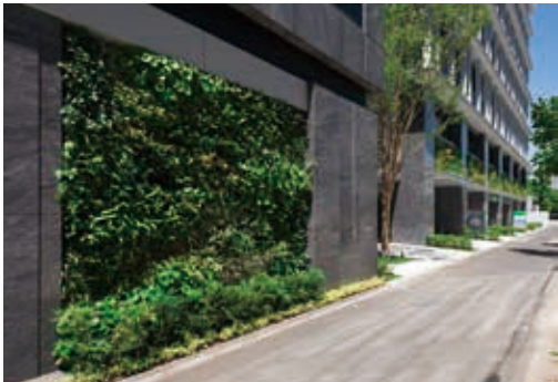
壁面緑化(別館)
