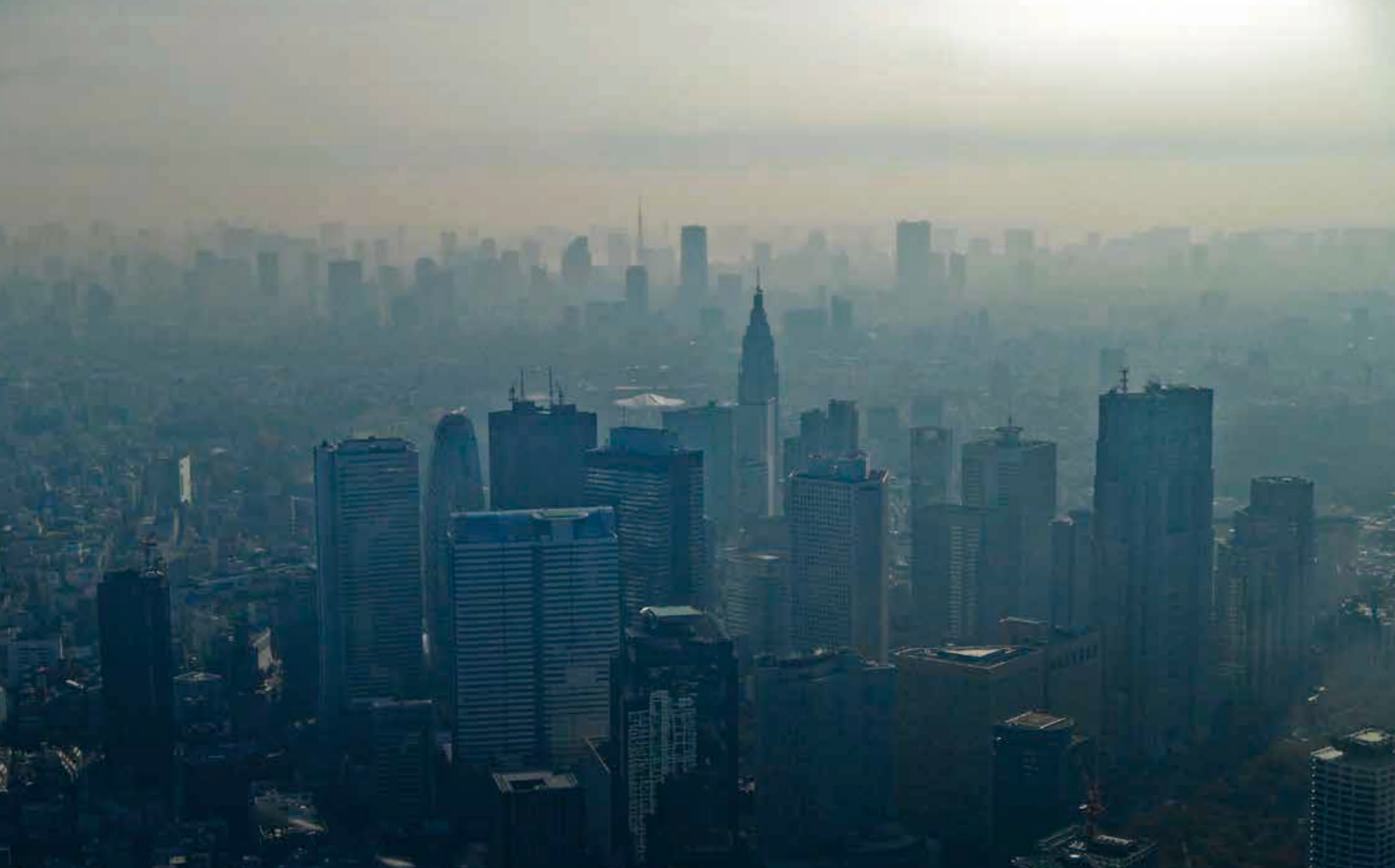
西新宿上空より / Aerial view of Nishi-Shinjuku
